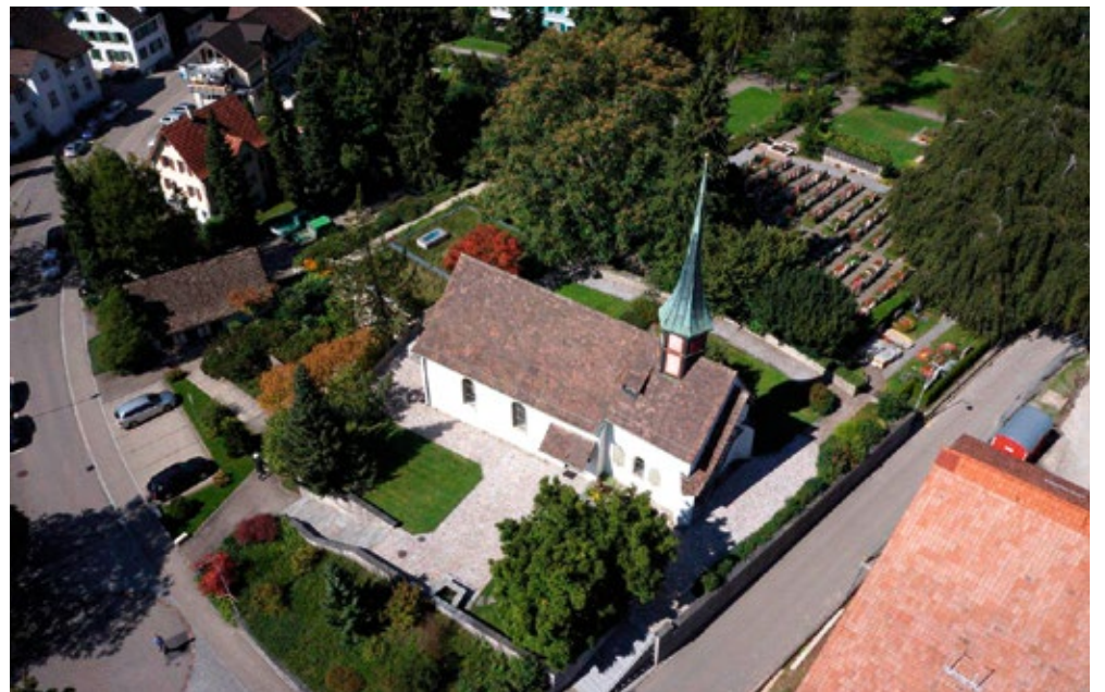
Entwässerungsleitungen sanierungsbedürftig · Foto: SKIVE Aviation AG
