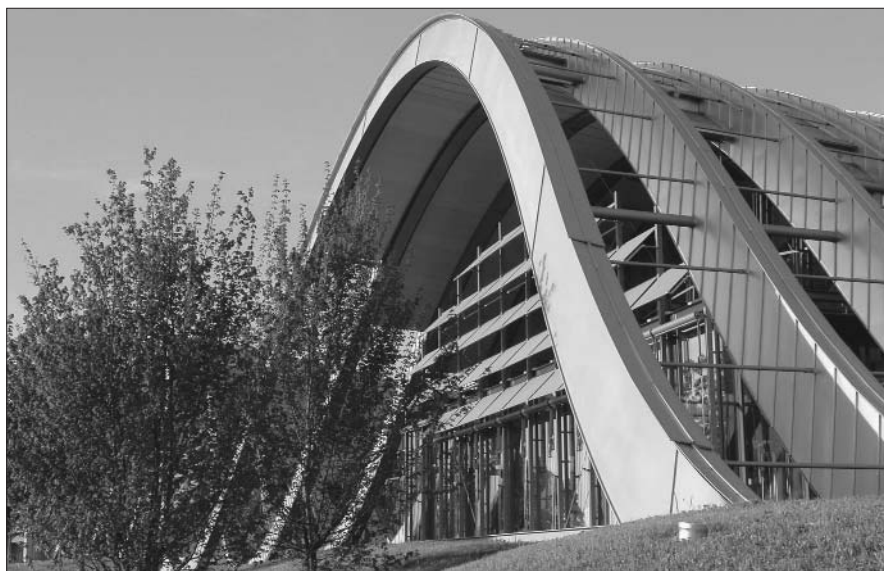
Architekt Renzo Pianos bauliche «Visionen für Klee».
