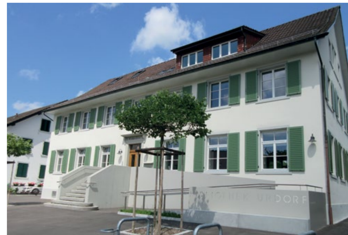
Die Gemeindebibliothek im alten Bachschulhaus bietet der Bevölkerung ein vielseitiges Angebot.
